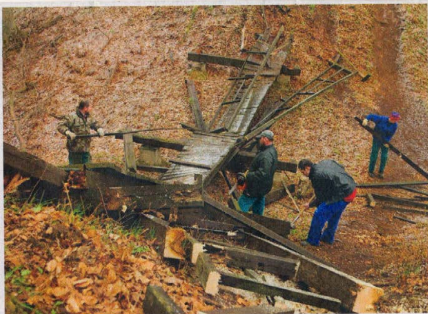
LIKVIDACE LÁVKY v hradním příkopu.
