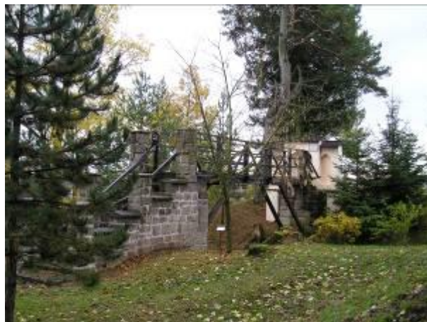
30) Dřevěná zámecká lávka, foto Pavla Puposvá - prosinec 2007
